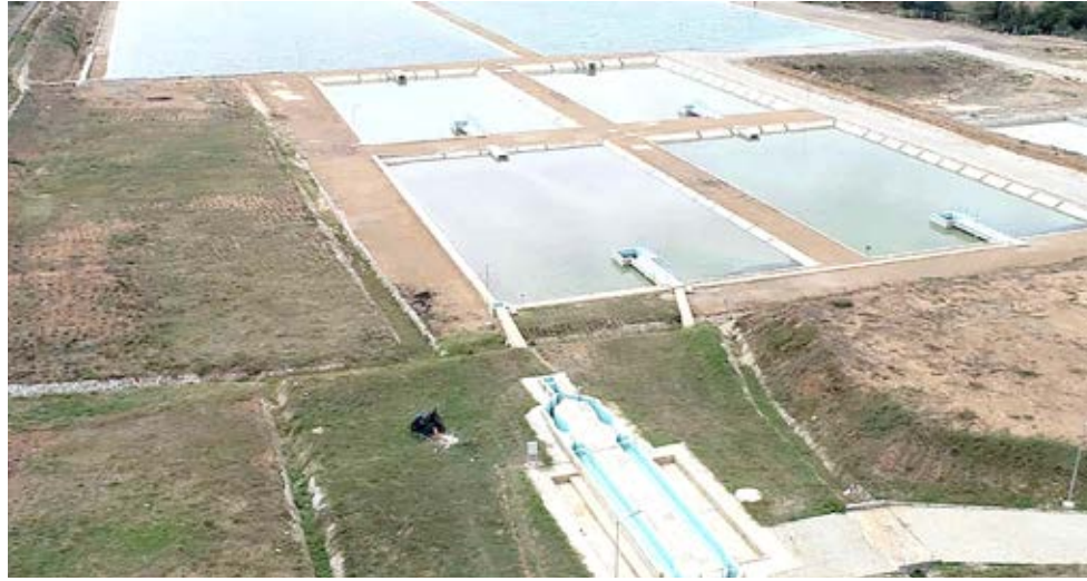
Picha kutoka juu ya mfumo wa kuzoa maji taka mjini Narok
