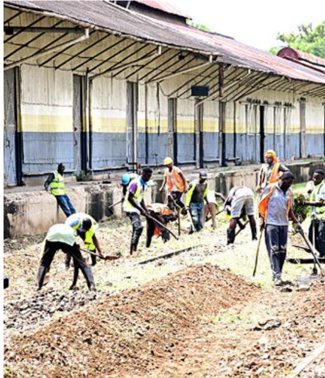
Ukarabati wa Njia ya Reli ya Meter Gauge ukiendelea katika Kituo Kikuu cha Reli cha Mombasa. Picha/Cyzick Sidayi
