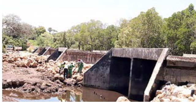
Shughuli za ujenzi wa mradi wa Funzi Island Causeway katika Kwale unaendelea kushika kasi.
