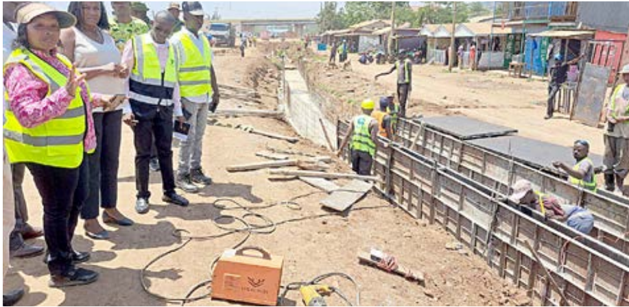
Mkuu wa Mkoa wa Nyanza Flora Mworoo (wa pili kushoto) akiarifiwa na Mhandisi Mkazi kuhusu hatua ambayo imefikiwa katika ujenzi wa barabara ya Kisumu-Mi-wani-Chemelil-Muhoroni-Kipsitet katika makutano ya Mamboleo. Alikuwa ameandamana na Mkurugenzi wa Kitengo cha Rais cha Utekelezaji wa Miradi Eneo la Magharibi Sylvance Osele (wa pili kulia) wakati wa ziara ya Kamati ya Eneo la Nyanza Kuhusu Usimamizi, Uratibu na Utekelezaji wa Miradi ya Maendeleo, mnamo Jumatatu.
