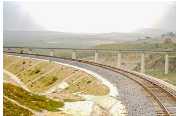
Sehemu ya Reli ya kawaida ambayo itaunganishwa na reli ta SGR kutoka kituo cha SGR cha Mombasa hadi kituo cha reli kilicho ndani ya mji wa Mombasa.
