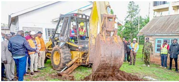
Gavana wa Kaunti ya Kericho, Dkt. Eric Mutai, aongoza hafla ya uzinduzi wa ujenzi wa Hospitali ya Ngazi ya Nne ya Sosiot yenye ghorofa tatu, yenye thamani ya Shilingi milioni 158.
