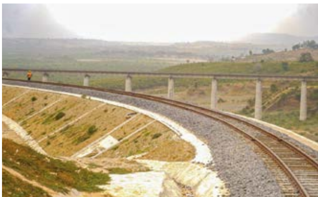
Sehemu ya Reli ya Meter Gauge (MGR) ambayo itaunganishwa na Standard Gauge Railway kutoka Mombasa SGR Terminus hadi Kituo Kikuu cha Mombasa.
