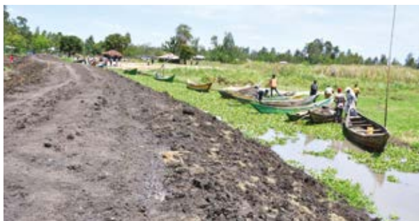
Mradi unaoendelea wa Kudhibiti Mafuriko wa Kano Magharibi wa Kanyagwal ambao unahusisha ujenzi wa njia ya maji yenye urefu wa mita 1.5 yenye urefu wa kilomita 3.5 na daraja la miguu katika Lokesheni Ndogo ya Ogenya, Kaunti ya Kisumu.
