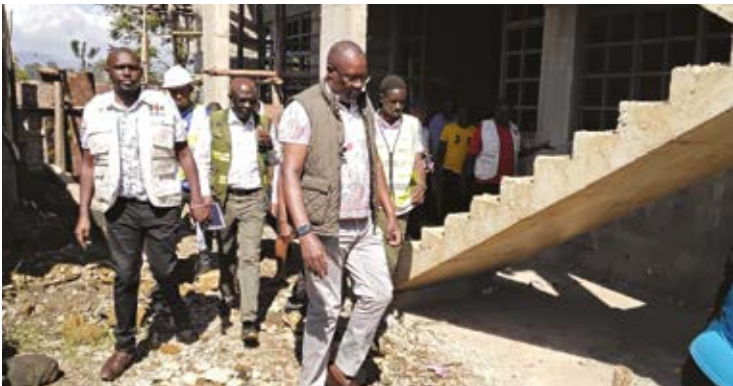
Naibu Afisa Mkuu wa Ofisi ya Rais Mtendaji Dkt. Eliud Owalo (mbele) akiongoza timu kutoka Kitengo cha Utoaji Huduma za Serikali kukagua ujenzi unaoendelea wa jengo la mama na mtoto katika hospitali ndogo ya Endebess huko Trans Nzoia.
